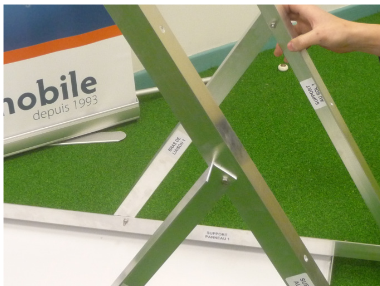
Etape 3 : Raccord bras de liaison aux supports sol et panneau
