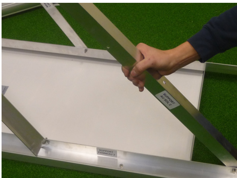
Etape 3 : Raccord bras de liaison aux supports sol et panneau
